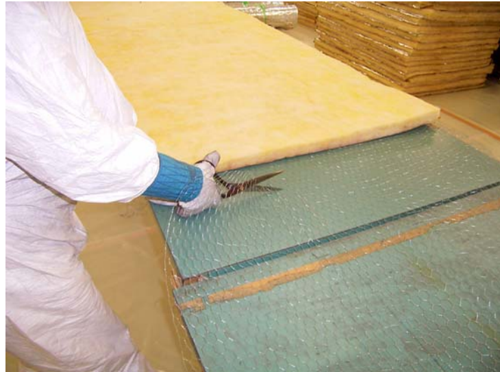
脱落防止のためタッカー打ち
