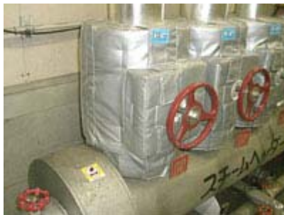
▲当社が推進している工断熱は省エネ&コストダウンに大きく貢献しています。
