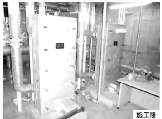
第2図 保温していないプレート熱交換器とヒートキャップを取り付けたプレート熱交換器
