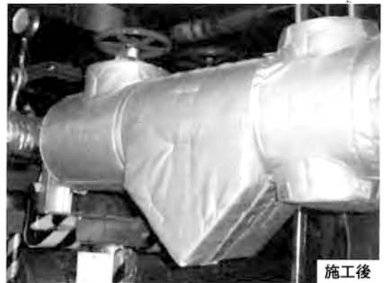
第1図 保温していないY型ストレーナーとヒートキャップを取り付けたY型ストレーナー
