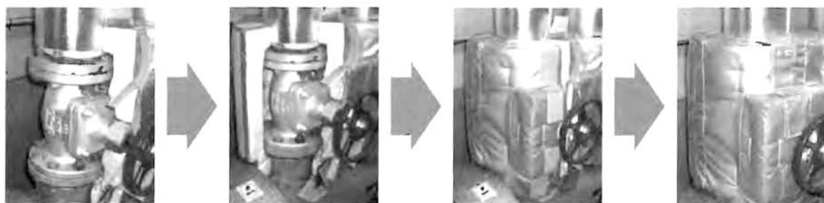
第3図 ヒートキャップの取り付け工程
