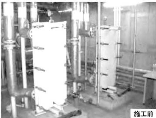
第2図 保温していないプレート熱交換器とヒートキャップを取り付けたプレート熱交換器
