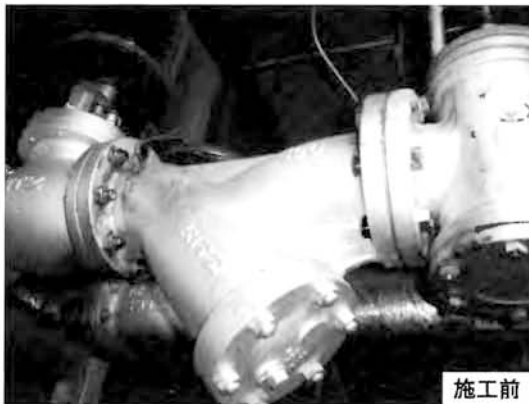
第1図 保温していないY型ストレーナーとヒートキャップを取り付けたY型ストレーナー
