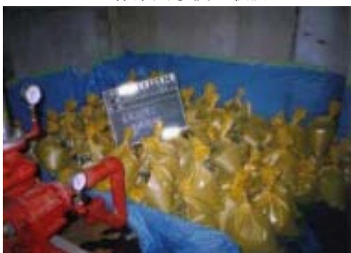
吸引石綿 袋詰め
