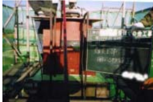
煙突上部に機械取り付け
