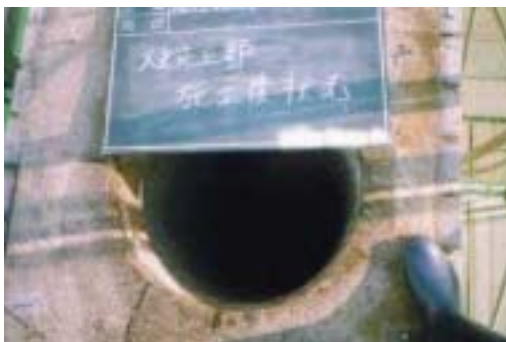
作業終了後 状況
