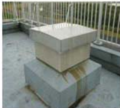
応急処置後の煙突状況
