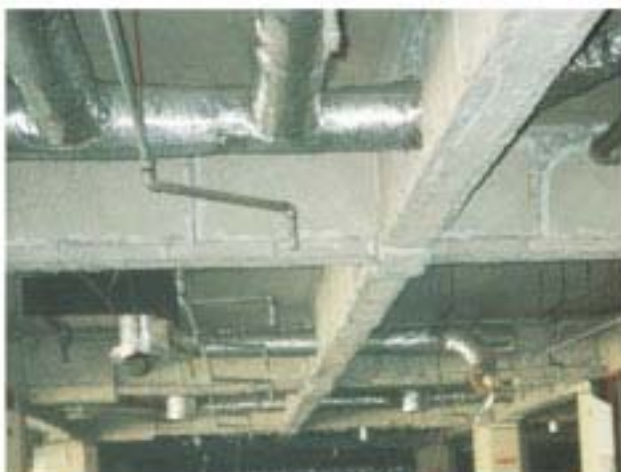
鉄骨耐火被覆
