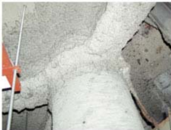
鉄骨耐火被覆
