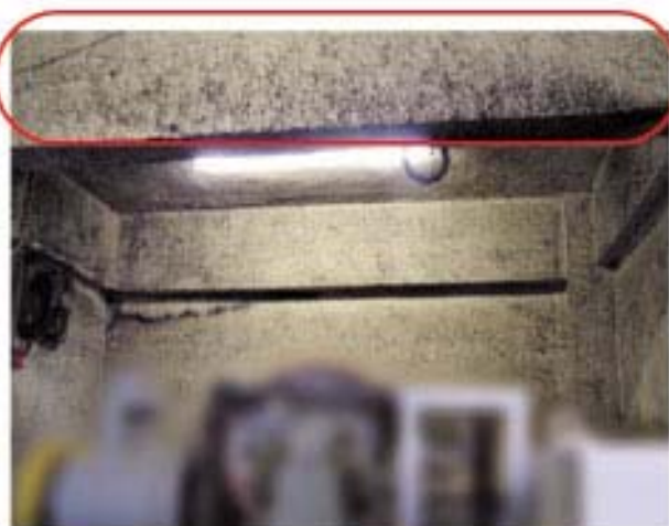
機械室吸音材
