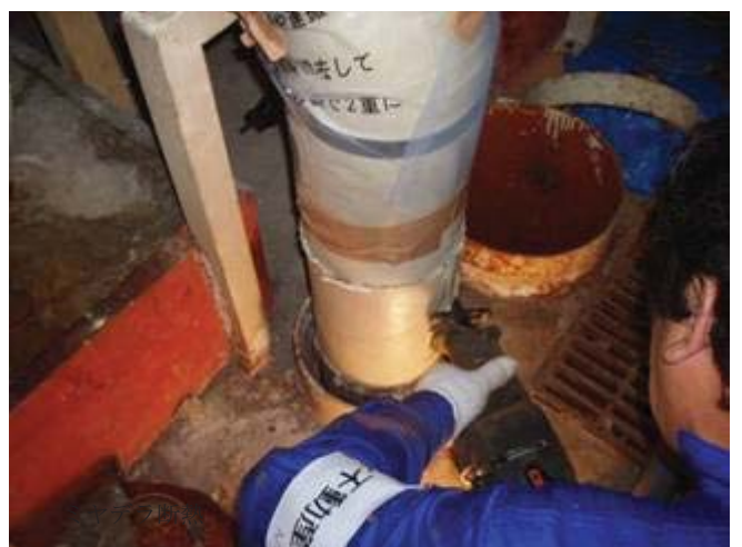
切断部保温材撤去
