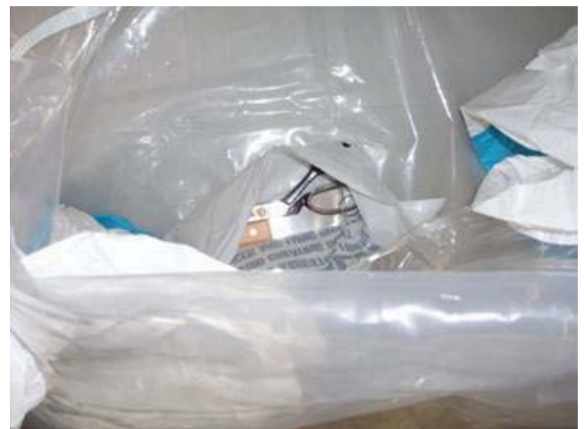
グローブバッグ取り付け完了
