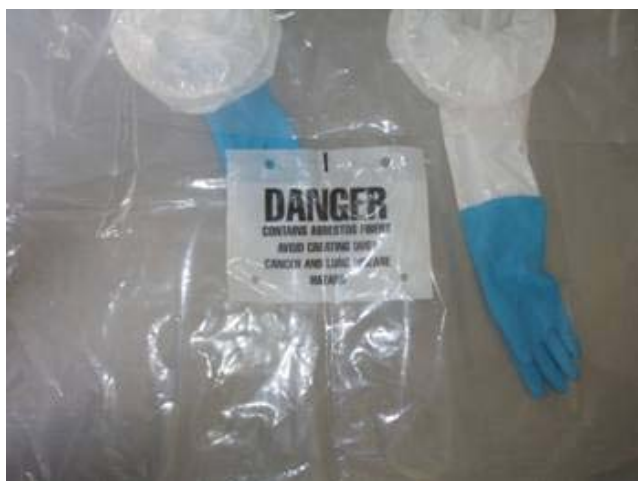
グローブバッグ取り付け作業
