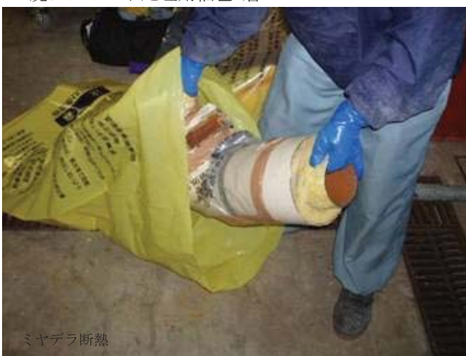
廃アスベスト処理用梱包1層
