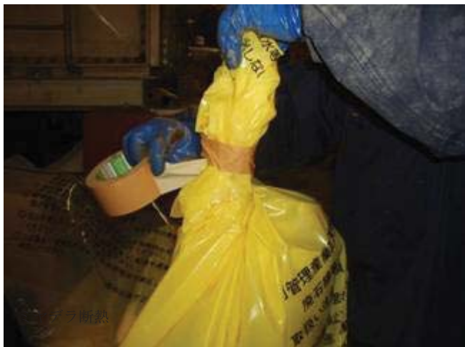
廃アスベスト処理用梱包1層目折り返し
