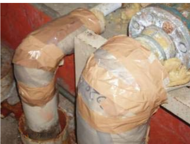
切断部 保温材撤去
