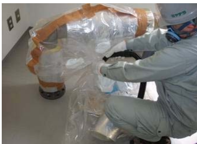
グローブバッグ取り外し作業
