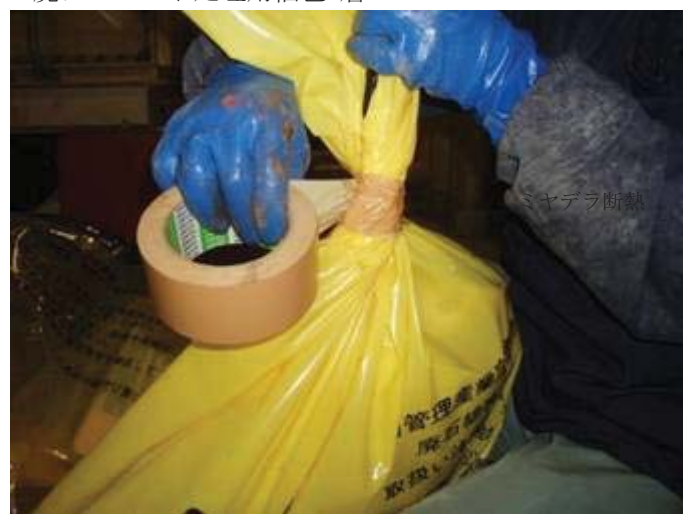
廃アスベスト処理用梱包1層
