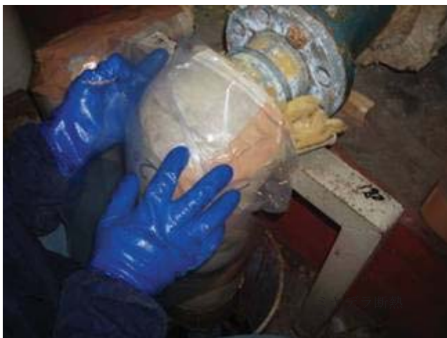
切断部 保温材撤去
