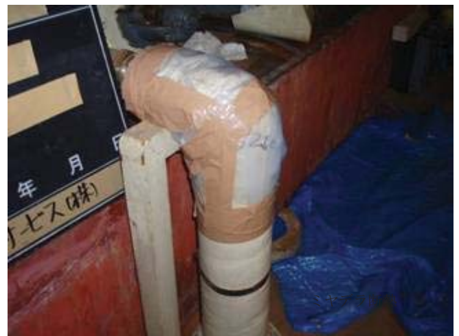
切断部保温材撤去
