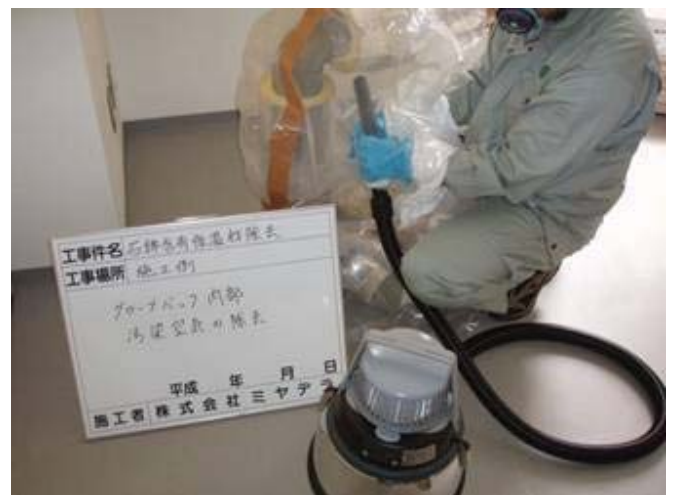
内部 汚染空気の除去
