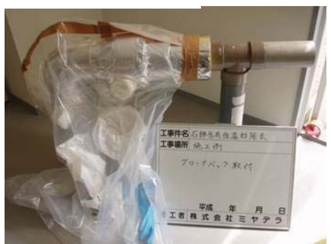
グローブバッグ取り付け完了
