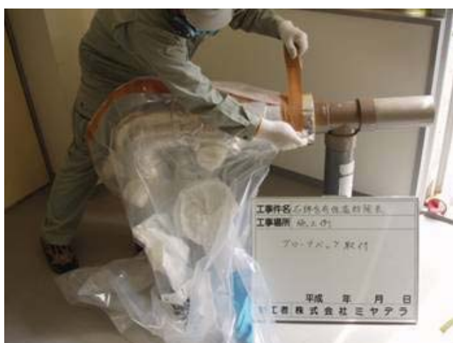
グローブバッグ取り付け作業
