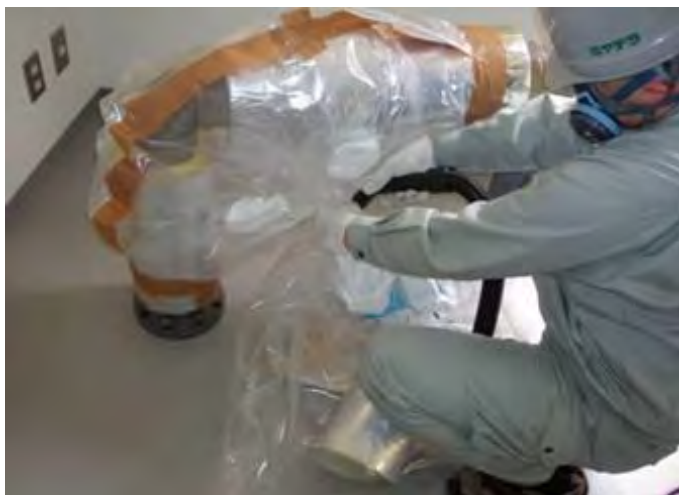
グローブバッグ取り外し作業
