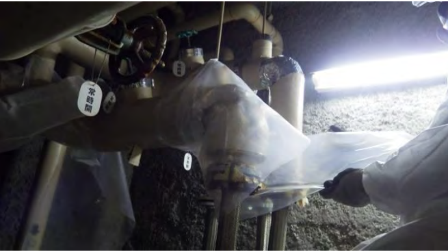
配管切断による除去
