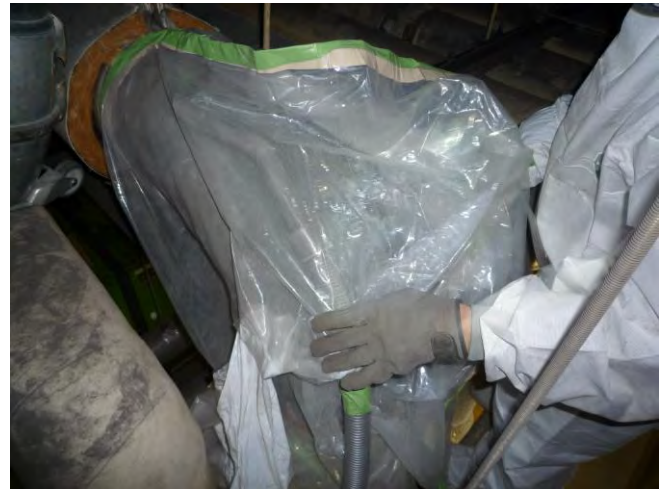
飛散防止薬剤液 浸透
