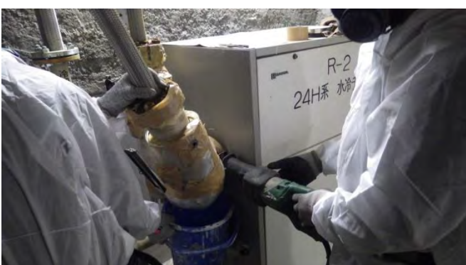
配管切断による除去③
