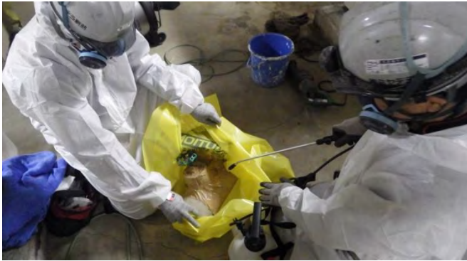
アスベスト廃棄物専用袋にて二重梱包④二重目完了
