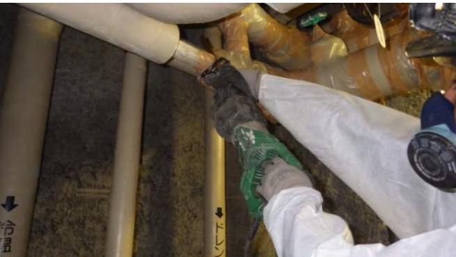
配管切断による除去③
