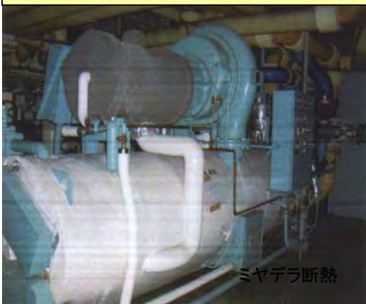
保温材が露出されている場合
