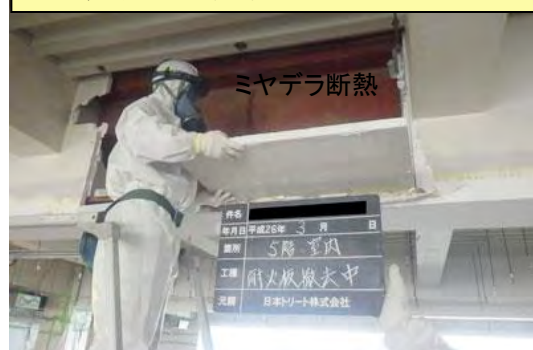
石綿含有耐火被覆板撤去作業
