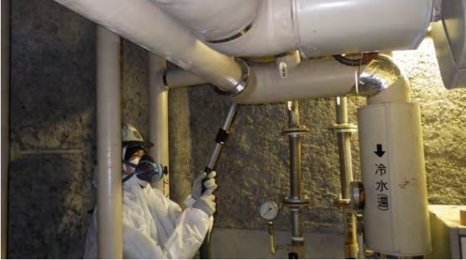
撤去前養生 石綿使用部位の養生
