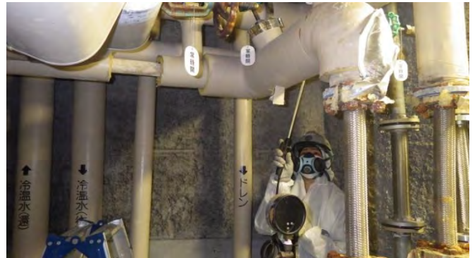
撤去前養生 石綿使用部位の養生完了
