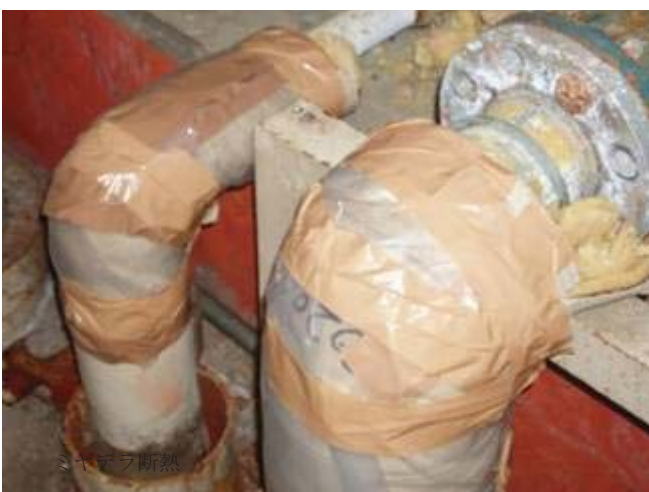
切断部 保温材撤去
