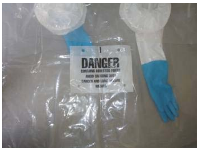
グローブバッグ取り付け作業
