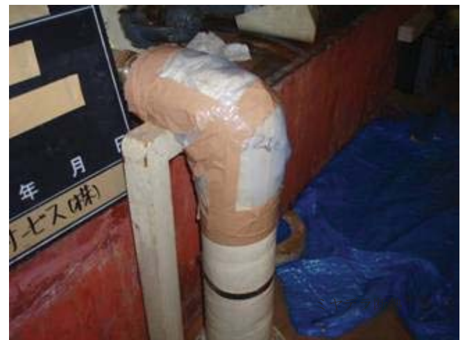
切断部保温材撤去
