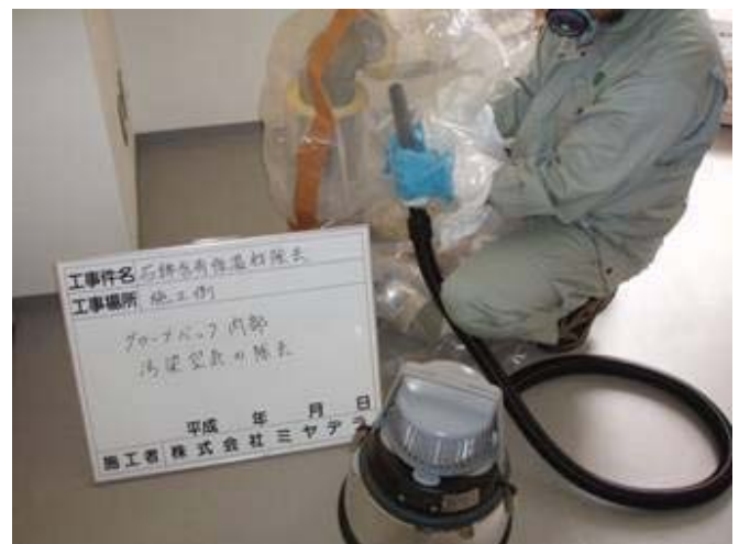
内部 汚染空気の除去
