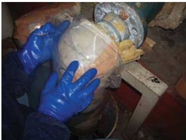
切断部 保温材撤去
