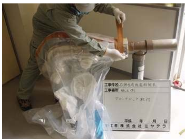
グローブバッグ取り付け作業
