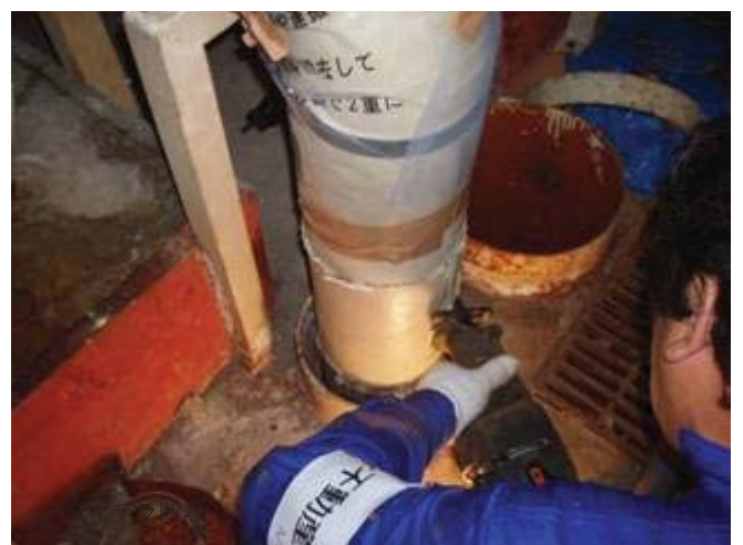
切断部保温材撤去
