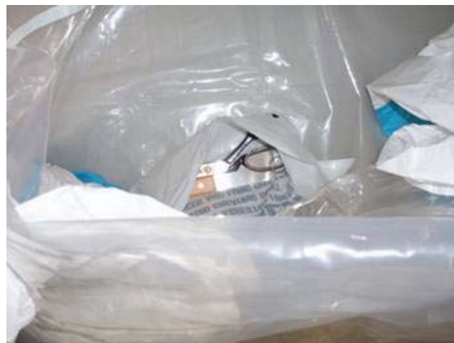
グローブバッグ取り付け完了
