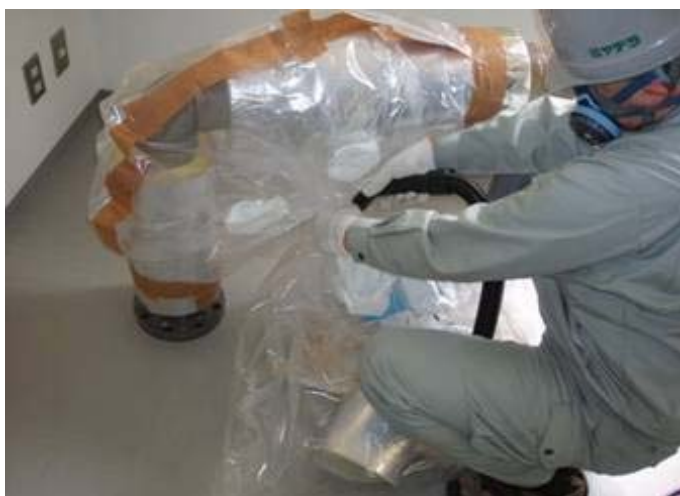
グローブバッグ取り外し作業
