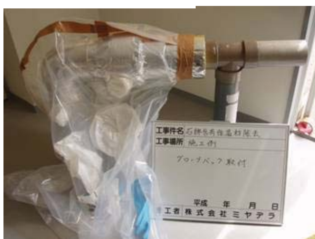
グローブバッグ取り付け完了
