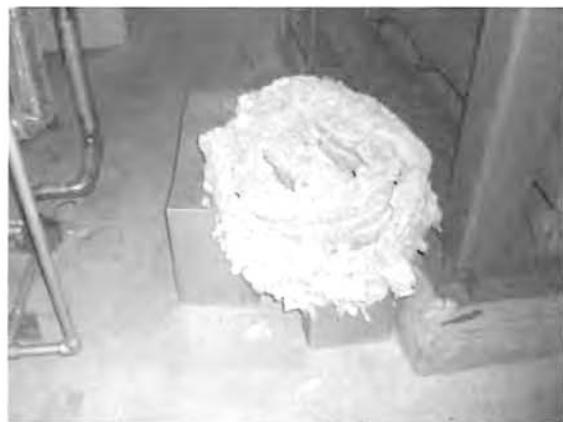
写真1 復旧されず放置された保溫材
