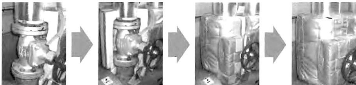
第3図 ヒートキャップの取り付け工程
