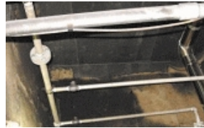
保温されていない配管・バルブ部
