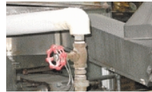
保温されていない配管・バルブ部
