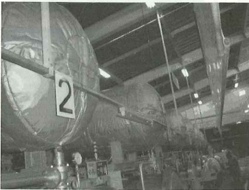
写真4 貯湯槽に装着
